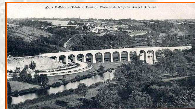
Le viaduc en 1904
